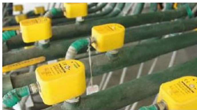
流量开关检测管道内冷却水状况
